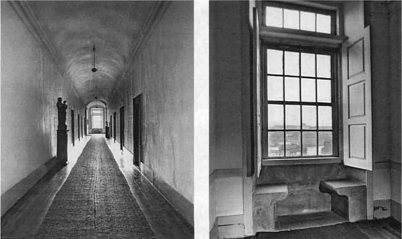
Corredor e Janela Conversadeira do Colégio de S. Lourenço do Porto
